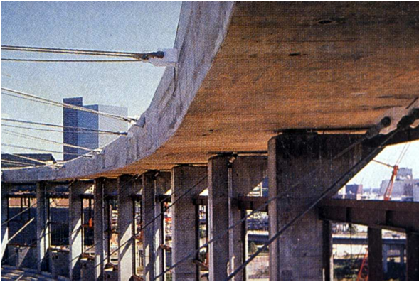
Figura 1. Anillo de compresión del Georgia Dome , Atlanta, 1992 (de http://www.columbia.edu/cu/gsap/BT/DOMES/domes.html ).
