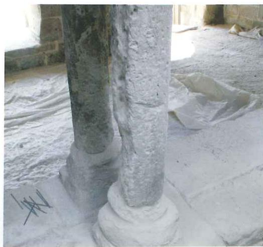
Fig. 4. Columnas erosionadas. | *Columnes erosionades.*
