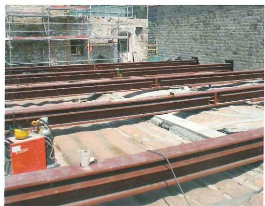
Fig. 12. Pórticos de acero que apean el muro central. | Pòrtics d'acer que estintolen el mur central.
