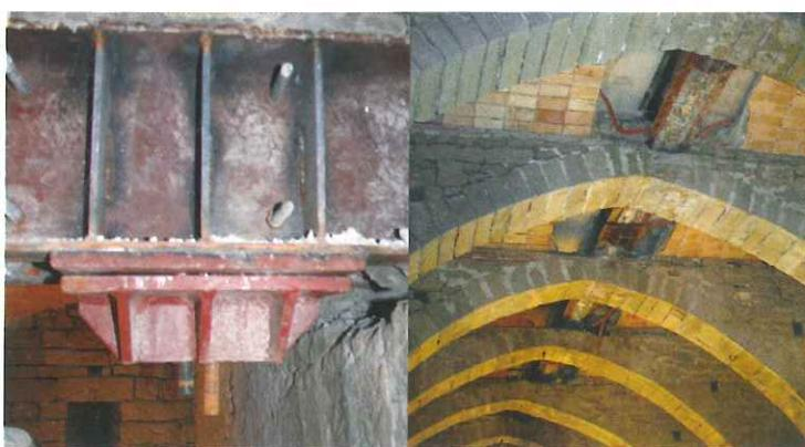
Fig. 10. Sistema de UPNs y placas de apeo en la base del muro. | Sistema d'UPNs i plaques d'estintolament a la base del mur.
