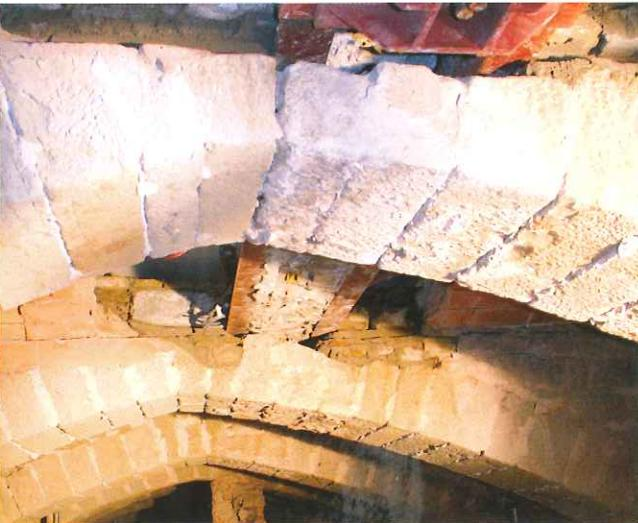
Fig. 15. Proceso de derribo progresivo del muro inferior a medida que se procede a la puesta en carga de los tirantes. | Procés de demolició progressiu del mur inferior a mida que es procedeix a la posta en càrrega dels tirants.
