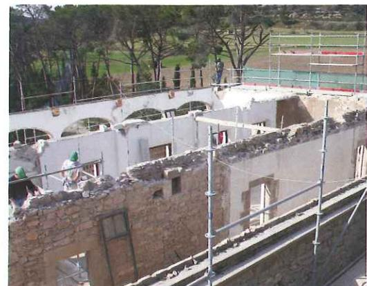
Fig. 11. Demolición de la estructura muraria bajo cubierta. | Demolició de l'estructura muraria sota coberta.
