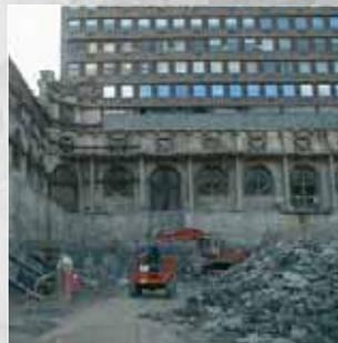
Tras esta nueva intervención constructiva, las imponentes fachadas del antiguo Depósito Franco, quedaron libres desde unos 7 metros de altura hasta su coronación, por lo que fue necesario apuntalarlas desde el exterior del depósito mediante una estructura metálica tubular contrapesada con sacos de arena.
