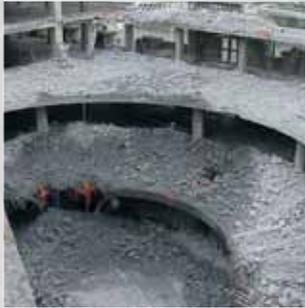
Hay que hacer notar, por su interés como medida de sostenibilidad, que todo el volumen de escombros, fundamentalmente hormigón armado, se procesó para separar el acero del hormigón y se recicló como chatarra y como material usable para bases de carreteras. En este caso forma parte del nuevo puerto de Bilbao.
