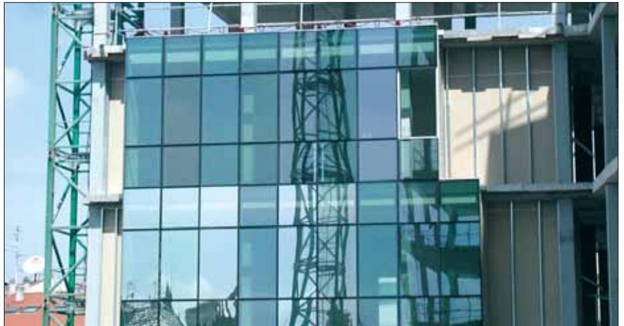
*Maquetas del muro cortina a escala real*
