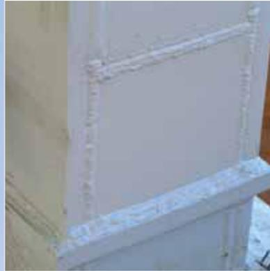
*Detalles de fijación de los pilares metálicos, replanteo en X, Y, Z con comprobaciones de coordenadas en cada planta*
