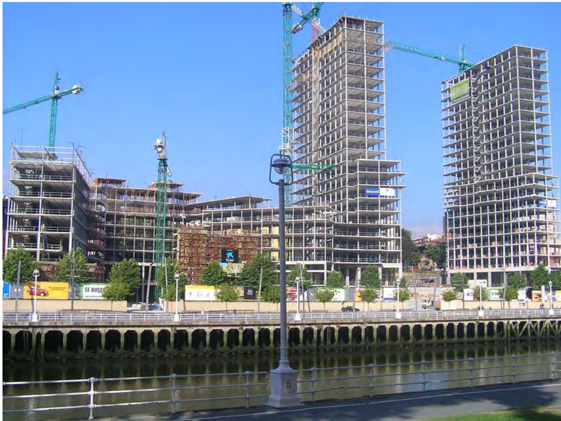
Figura 1.1 Vista de la obra al final de la construcción de la estructura (Julio de 2006)
