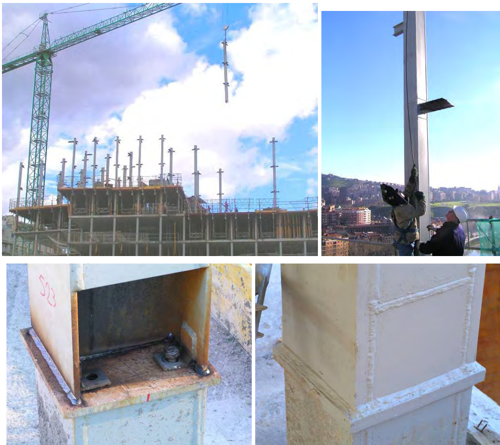
Figura 2.1 Etapas en el montaje de los pilares y realización de su unión según el comentario anterior
