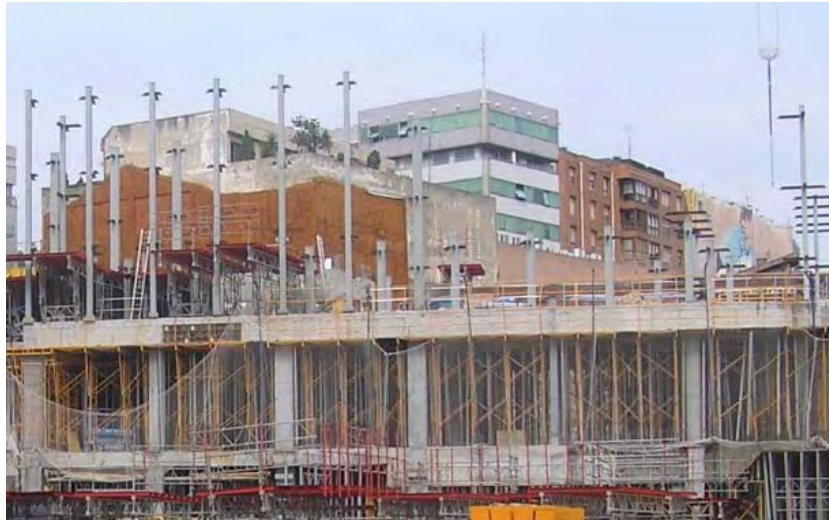
Figura 3.2 Hormigón armado y pilares de acero en la misma estructura.
