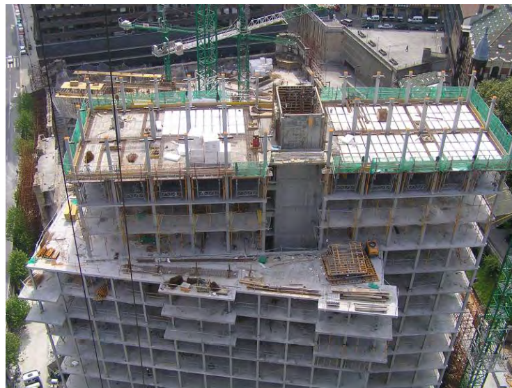
Figura 3.1 Núcleo central de hormigón de la nueva estructura.
